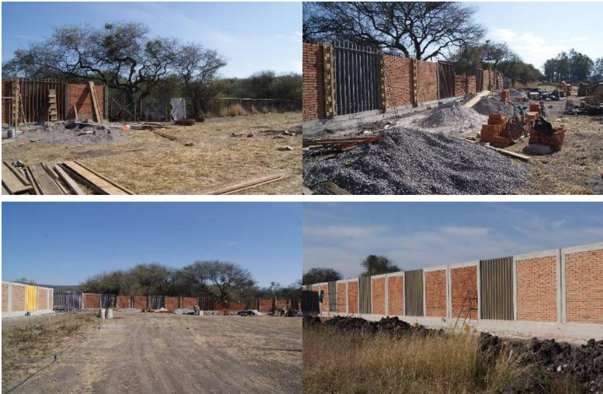
Figura 6. Terminación de la barda perimetral
